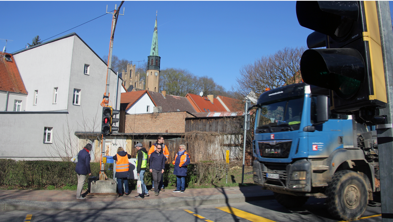
Wird gerade in Betrieb genommen: eine Bedarfsampel an der B 158 in Oderberg Foto: Oliver Köhler/Pressestelle LK Barnim
