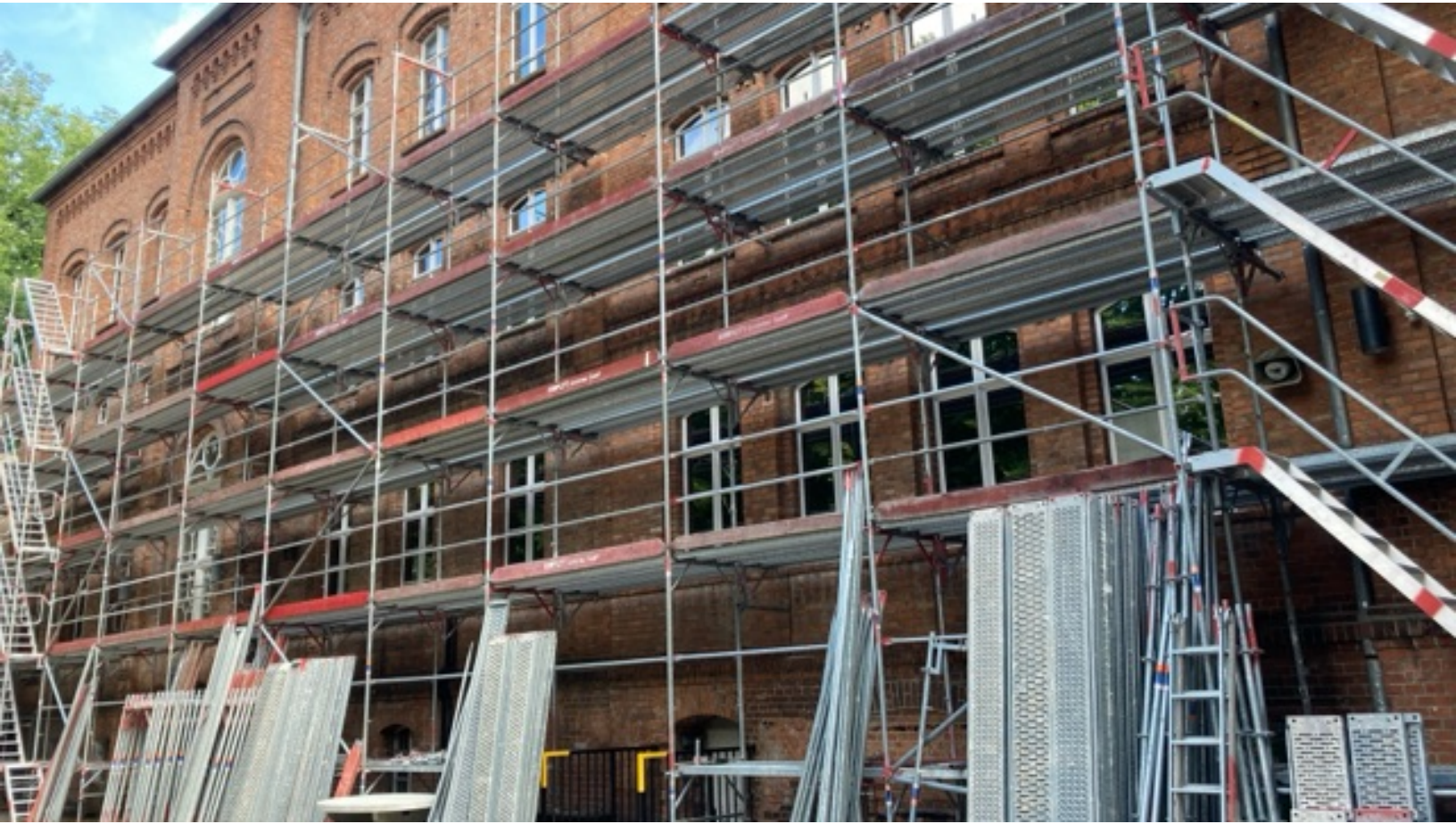
Denkmalgerechte Fassadensanierung an der Johanna-Schule in Bernau. Foto: Landkreis Barnim
